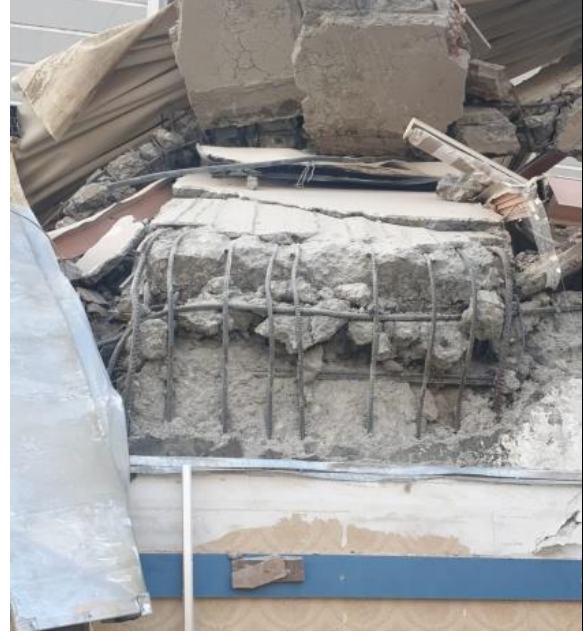
24-B: Kolonun Zayıf Yöne Eğilmesi
