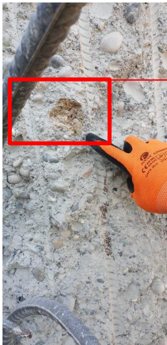
Resim 18: Grand Isias Otel Enkazındaki Kolon Betonu İçerisinde Gözlemlenen Toprak Parçası
