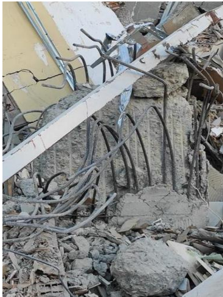
25-C: Kolonda Basınç Kırılması 3
