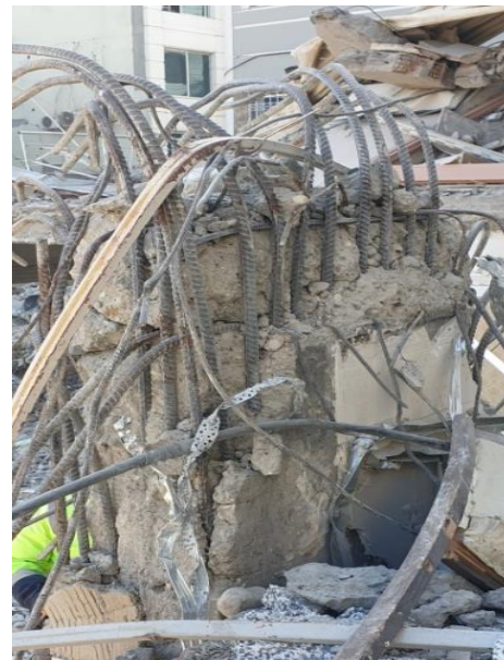
25-D: Kolonda Basınç Kırılması 4
