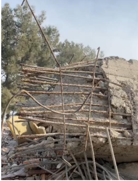
25-A: Kolonda Basınç Kırılması 1
