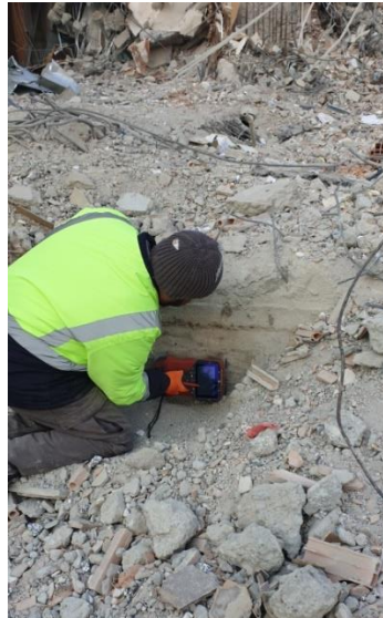
Resim 5: Grand Isias Otel Enkazında Bodrum Kat Perdesinden Numune Almadan Önce Yapılan Donatı Okuma İşlemi
