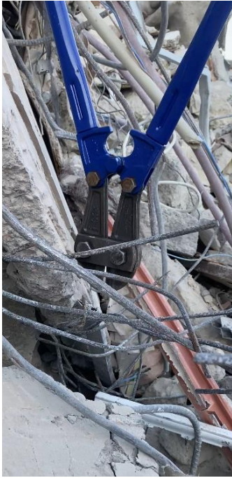
7-A: Örnek Çelik Donatı Çubuğu Alınma Aşaması
