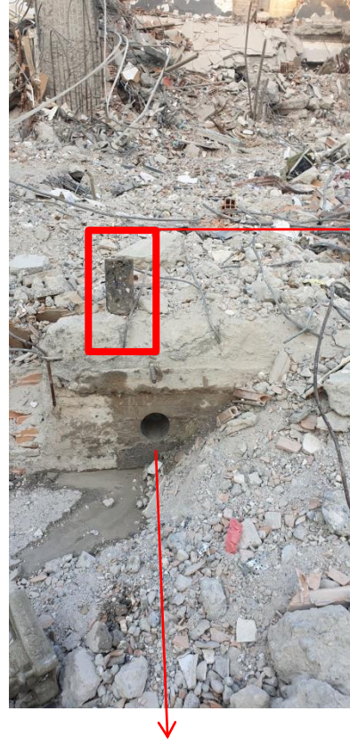
6-B: Numune No: 4 /Bodrum Kat Perde
