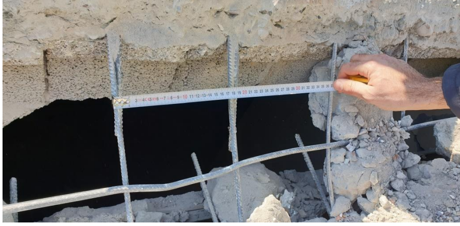
Resim 28: Grand Isias Otel'in Enkaz Alanında Ölçülen Asmolen Plaktaki Dağıtma Donatısı
