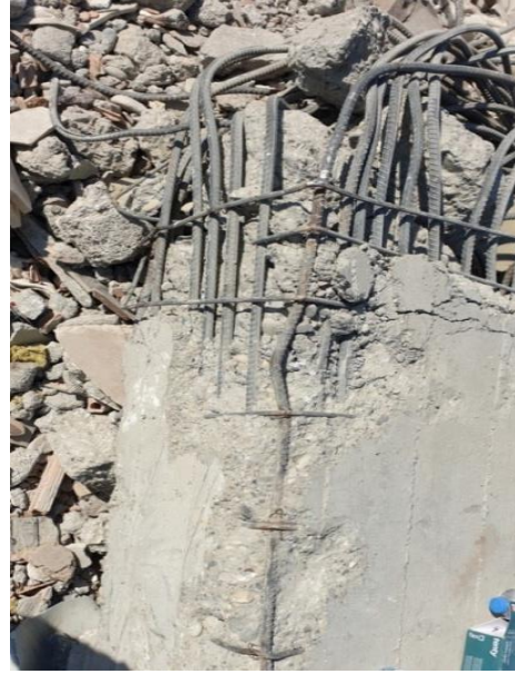
25-B: Kolonda Basınç Kırılması 2
